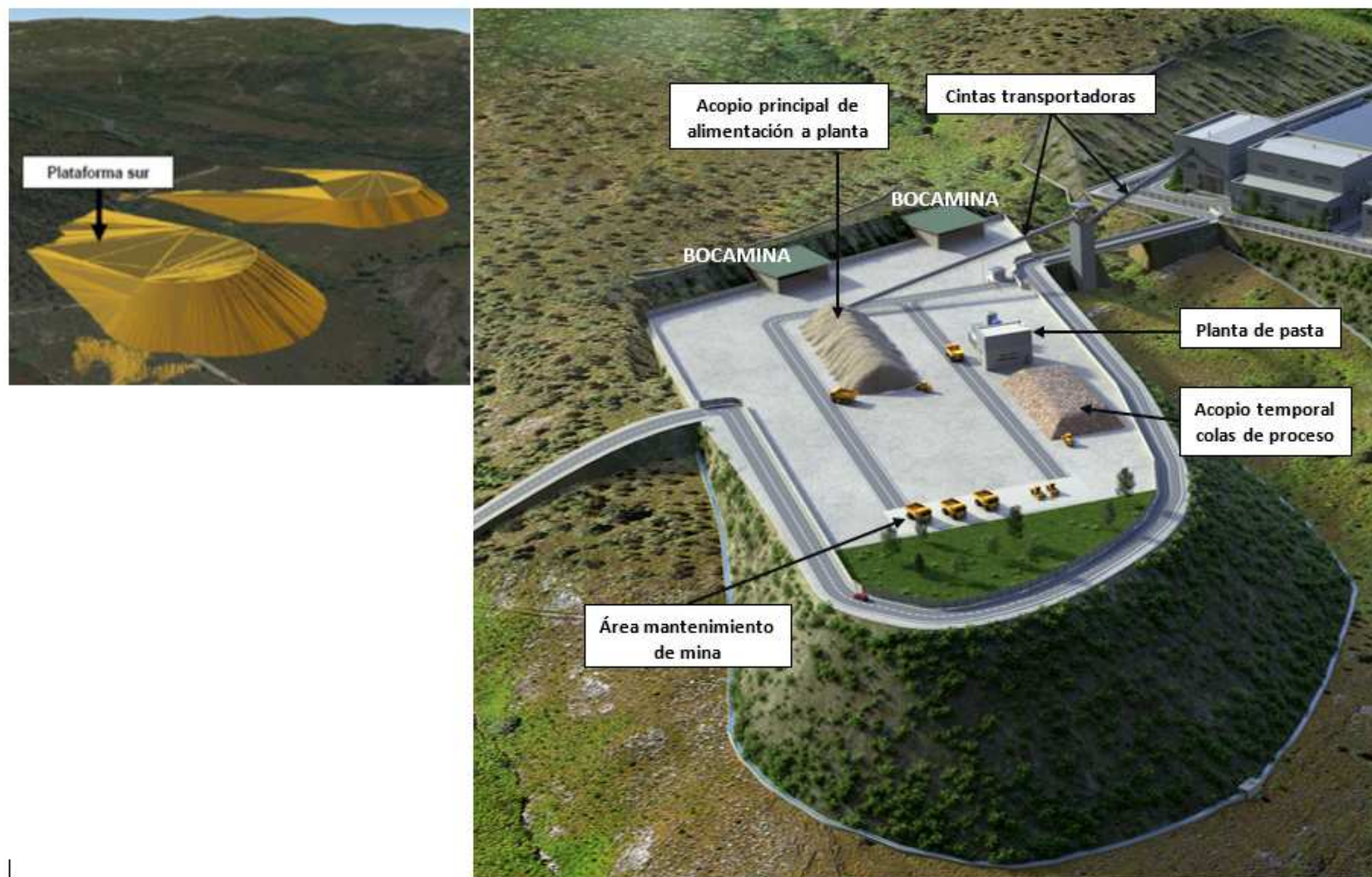
Vista general de la plataforma Sur.
